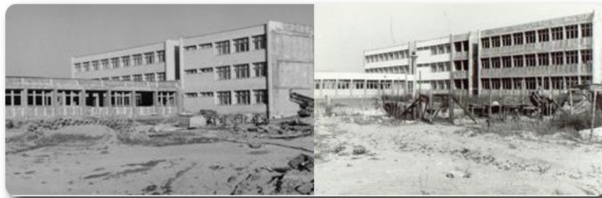
1. kép Az építkezés I. és II. üteme
